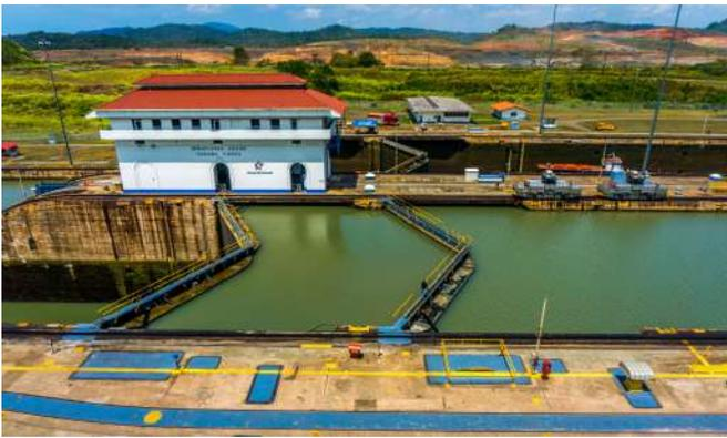
**米拉弗洛雷斯船閘**: 位於太平洋岸上的兩段式閘門, 船隻通過運河水閘門緩緩移動的操作情形。但由於太平洋海面比大西洋海面高 24 公分, 並且潮汐較高, 因此船隻必須進入一道水閘內, 透過水位調整, 才可讓船隻順利通過閘門。
